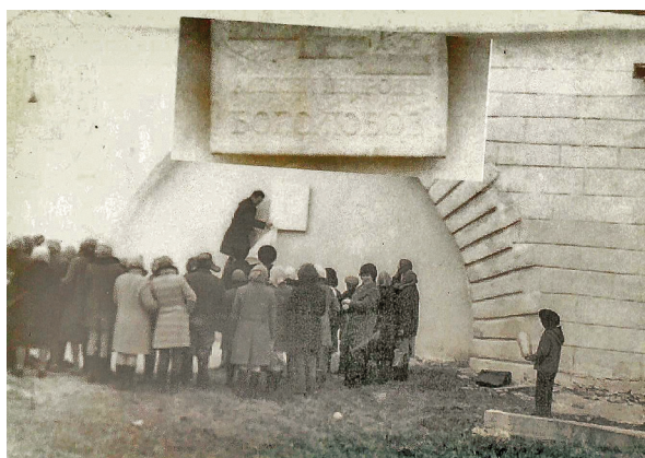
Установка мемориальной доски А. П. Боголюбову на почтовой станции Померанье. 1974 г.
