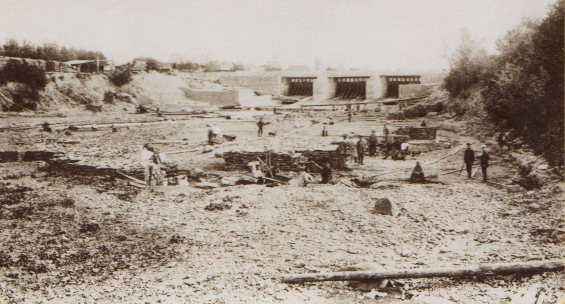
Саблино. Постройка новаго моста черезъ р. Тосно въ Гертовѣ.
