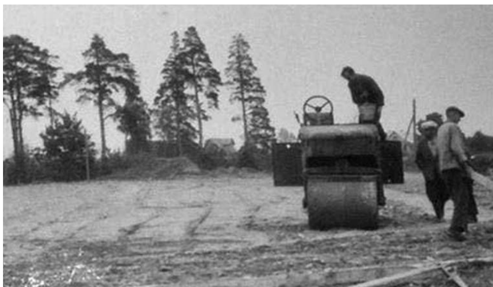
На строительстве школьного стадиона
