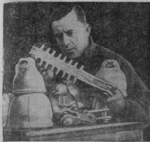
На Ленинградском чугунолитейном и арматурном заводе имени Лепсе изготовляется подвесная арматура для высоковольтной линии электропередачи Днэсо—Ленинград. На снимке: бригадир опытного цеха А. С. Шевцов проверяет качество опытной детали арматуры. Фото В. Федосеева (Фотохроника ТАСС)
